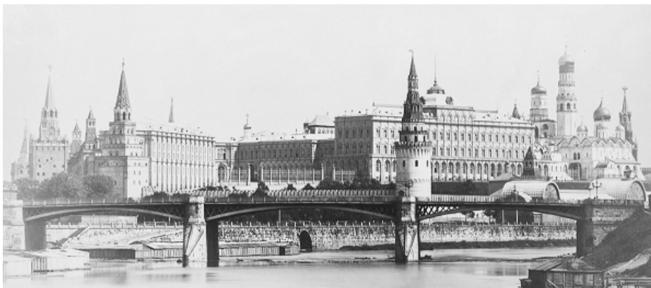
Рис. 5. Фотография 1 позволяет измерить длину моста
